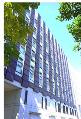
【参考】建材一体型太陽光パネル（外壁用）の設置事例（東京大学先端科学技術研究センター）
